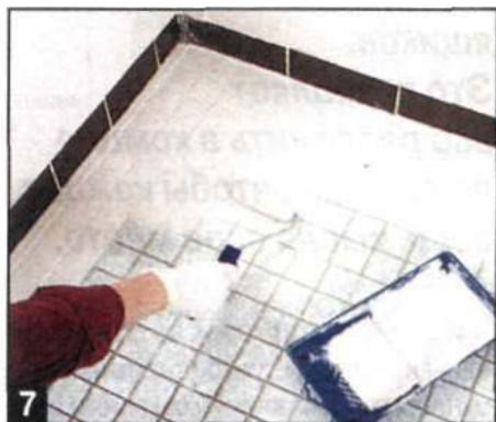
7 Таким же способом обновляют и пол. Однако учитывая, что пол испытывает значительно более интенсивные нагрузки, защитное покрытие здесь наносят в два слоя.
