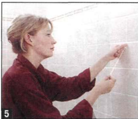
5 Сначала укладывают ленту в горизонтальные швы, затем — в вертикальные, прижимая ее в точках пересечения швов. После приклеивания ленты ее окончательно придавливают и в промежутках между точками пересечения.
