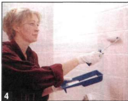
4 Нанесение цветного покрытия. Сначала кистью окрашивают швы, затем валиком — всю остальную поверхность (работать следует в защитных перчатках). Через 6-12 часов покрытие наносят второй раз. Продолжительность сушки этого второго покрытия — не менее 12 часов.
